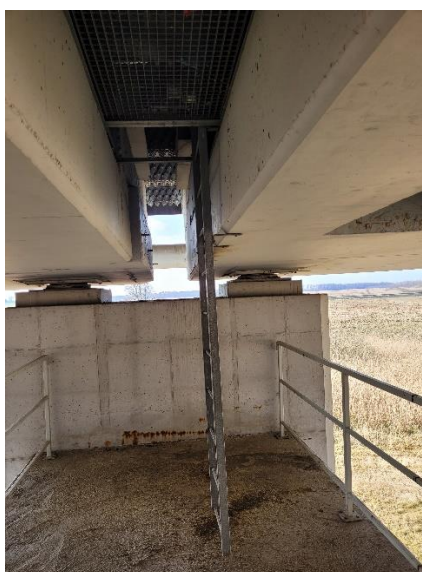
Widok przykładowej podpory pośredniej, gdzie występuje przestrzeń dylatacyjna.
