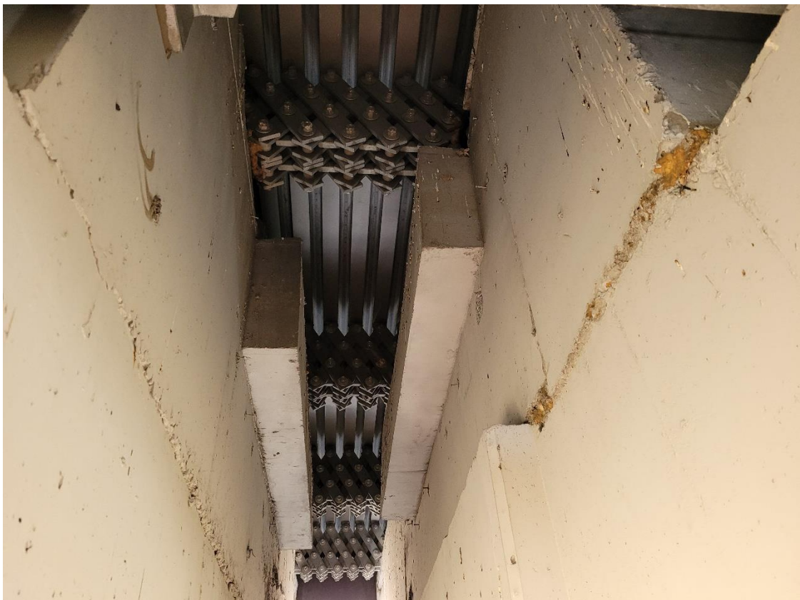
Widok przykładowej przestrzeni dylatacyjnej (przestrzeń pomiędzy przęsłami obiektu).
